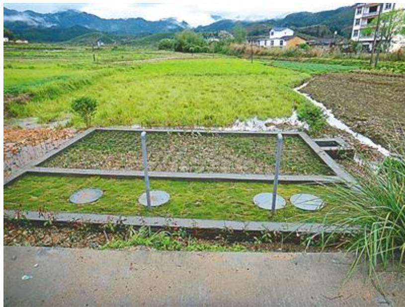
污水处理设施
